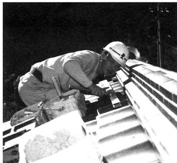
▲ 屋根で施工中の西宮氏
