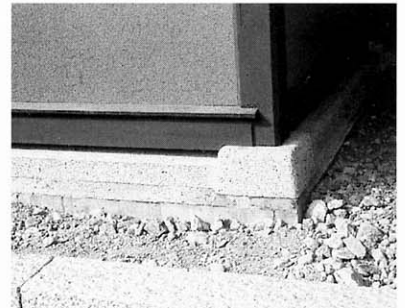
敷石上の10ミリほどの隙間から土台の上場・側面・下場に空気を送り、ムシや腐食を防ぐ
