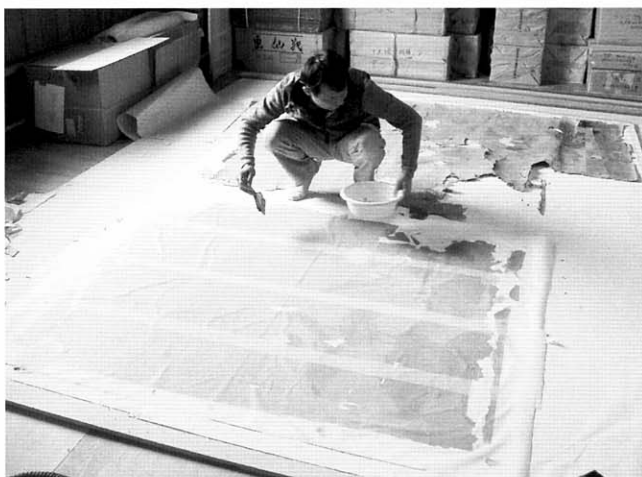
山門内部で壁画の修復作業を進める
