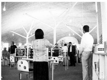
杉の無垢材約5千本がルーバー状に配されて3次元曲面の天井を形成している
