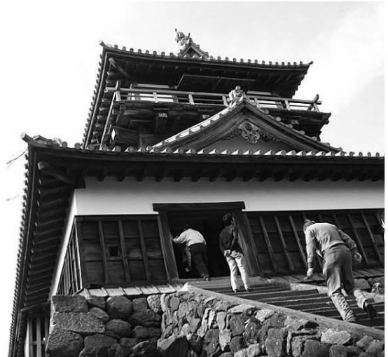
丸岡城天守閣（屋根瓦は地場産の石が使われている）
