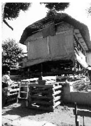
母屋を西に4.8m曳き家する工程
