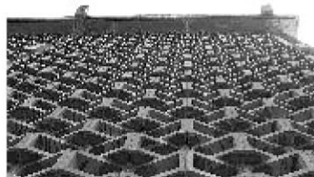
正面ファサードの穴あきPCブロック見上げ
