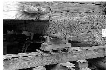
丸い鉄棒（画面中央下）が回転して、上の家屋を左方向へ移動。鉄棒の丸い部分にチョークで引かれた直径の線の回転で、微妙な移動の様子を判断する
