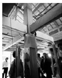
大きな貫の通る大黒柱と トップライトのある吹抜 けを見あげる
