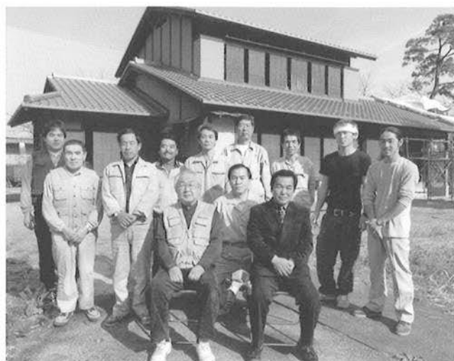
平成5年、東京都大田区にあった小林古径画伯の旧邸が解体され、平成10年から3年間にわたり新潟県上越市高田公園内に復原整備工事を行った。平成12年、母屋竣工時、携わった大林組の職人さんとの記念写真。
