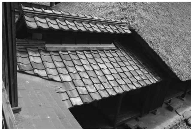
主屋屋根 茅葺・瓦・銅板葺。すべて名匠会の職人が関わった
