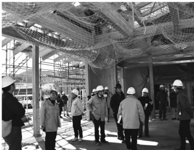
カラマツの集成材の登梁により自由度の高い空間が実現している
