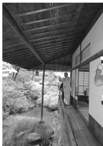
廣誠院 一本の捨て柱が、深い庇を支える
