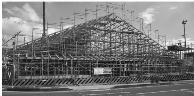
建設中の塩尻市北部拠点センター外観
