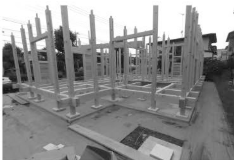
建て方（柱、足固め）
